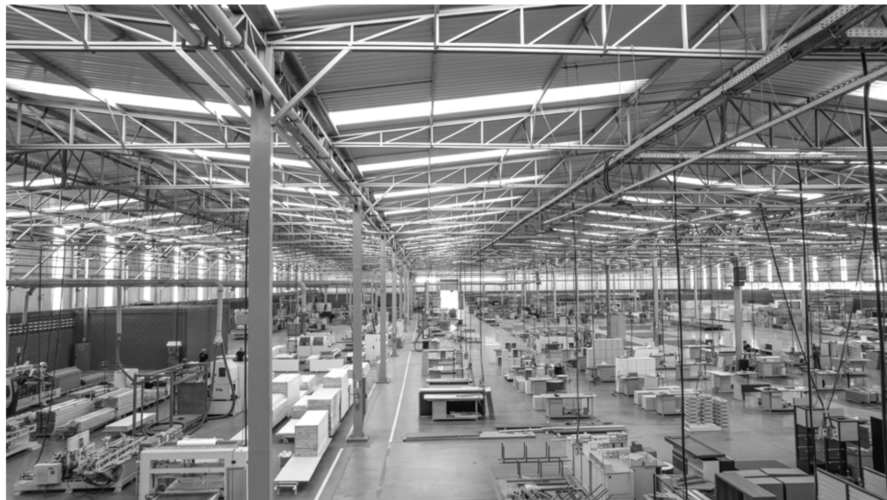
Fábrica Cali Portas
